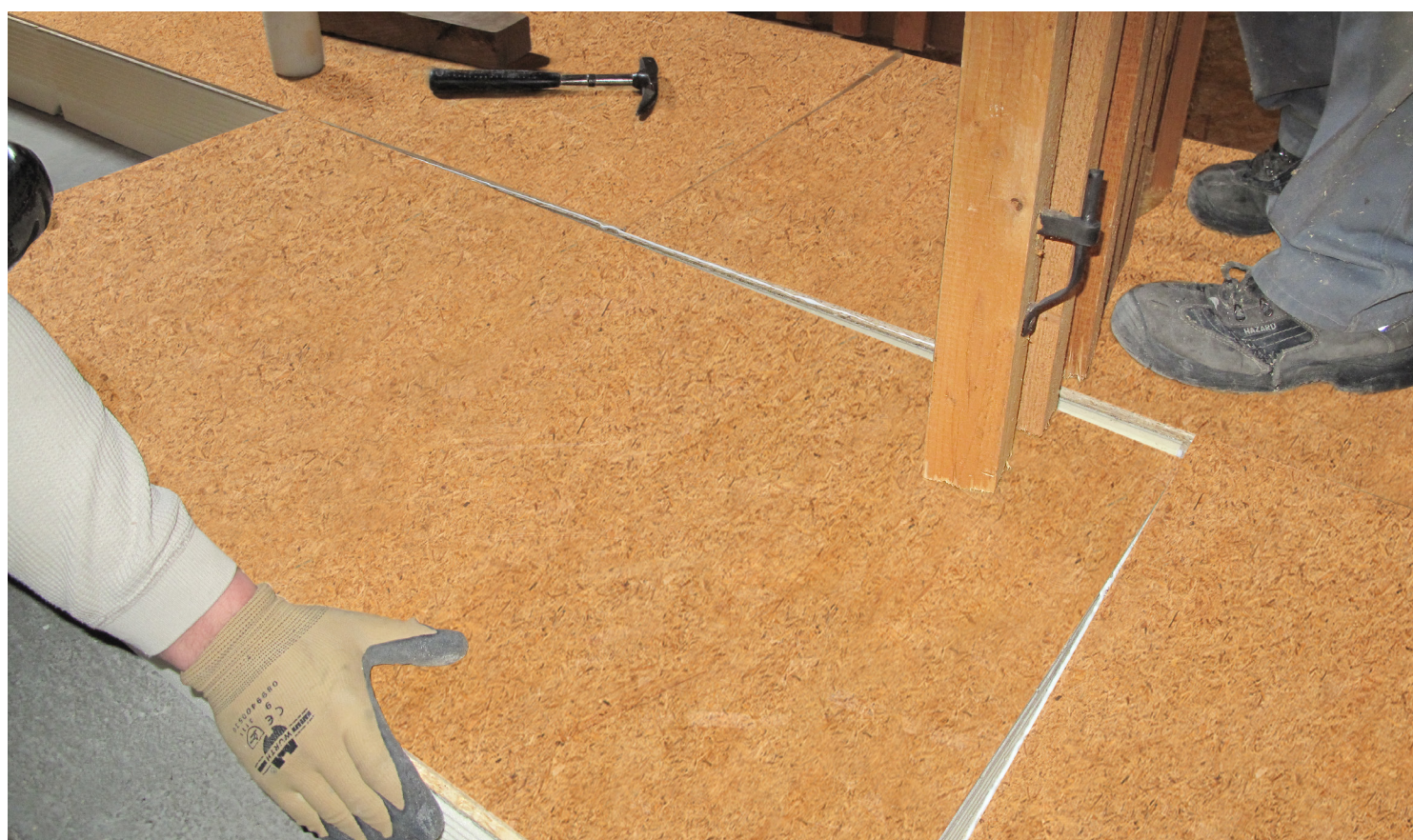
Élément pour comble LINITHERM PAL [R] ou PGV [R] Pare-vapeur PE LINITHERM 120 Plancher en bois Chevrons
