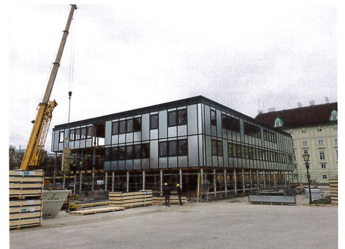
Bild 4. Montage der beiden kompakten, dreigeschossigen Holzmodul-Bürogebäude auf dem Heldenplatz – LINIT Verbundelemente bieten wegen ihres extrem schlanken Aufbaus maximale Dämmwerte bei extrem schlanken Wandaufbauten (Fotos 3 und 4: Lukas Lang Building Technologies)
