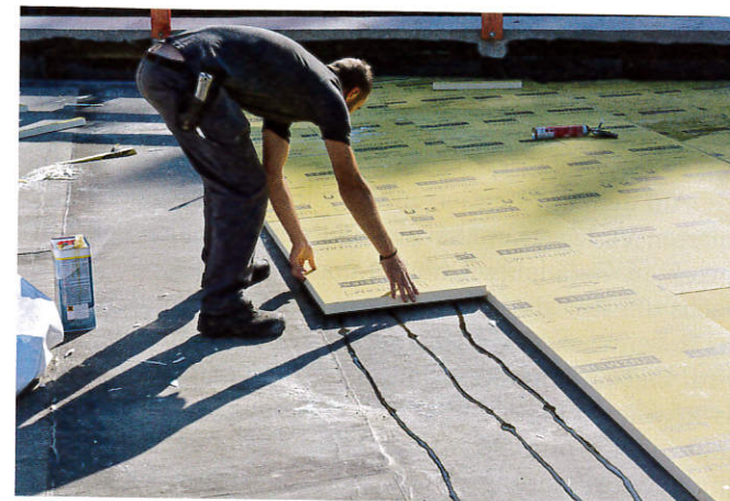
Bild 2. Verlegung der Platten LINITHERM PGV Gefälle
