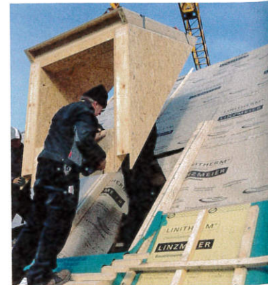
▶ ...und passgenau auf die Lagerhölzer aufgesetzt
