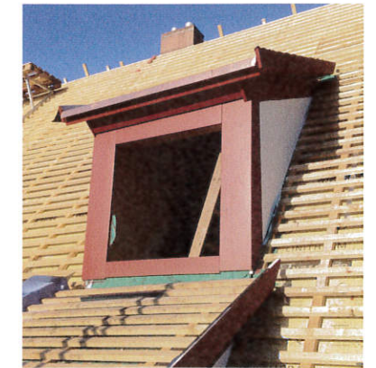
▶ Anbringung der roten Stirnleisten an den Gauben
