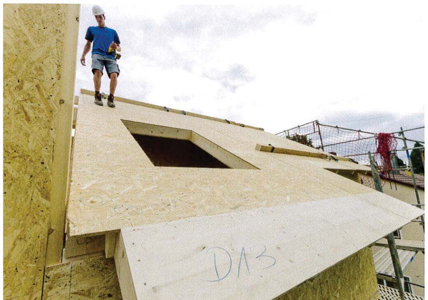
Dachelement mit Gaubenöffnung. Auch Gaubenbauteile gehören zum System und werden im gewünschten Vorfertigungsgrad mitgeliefert.
