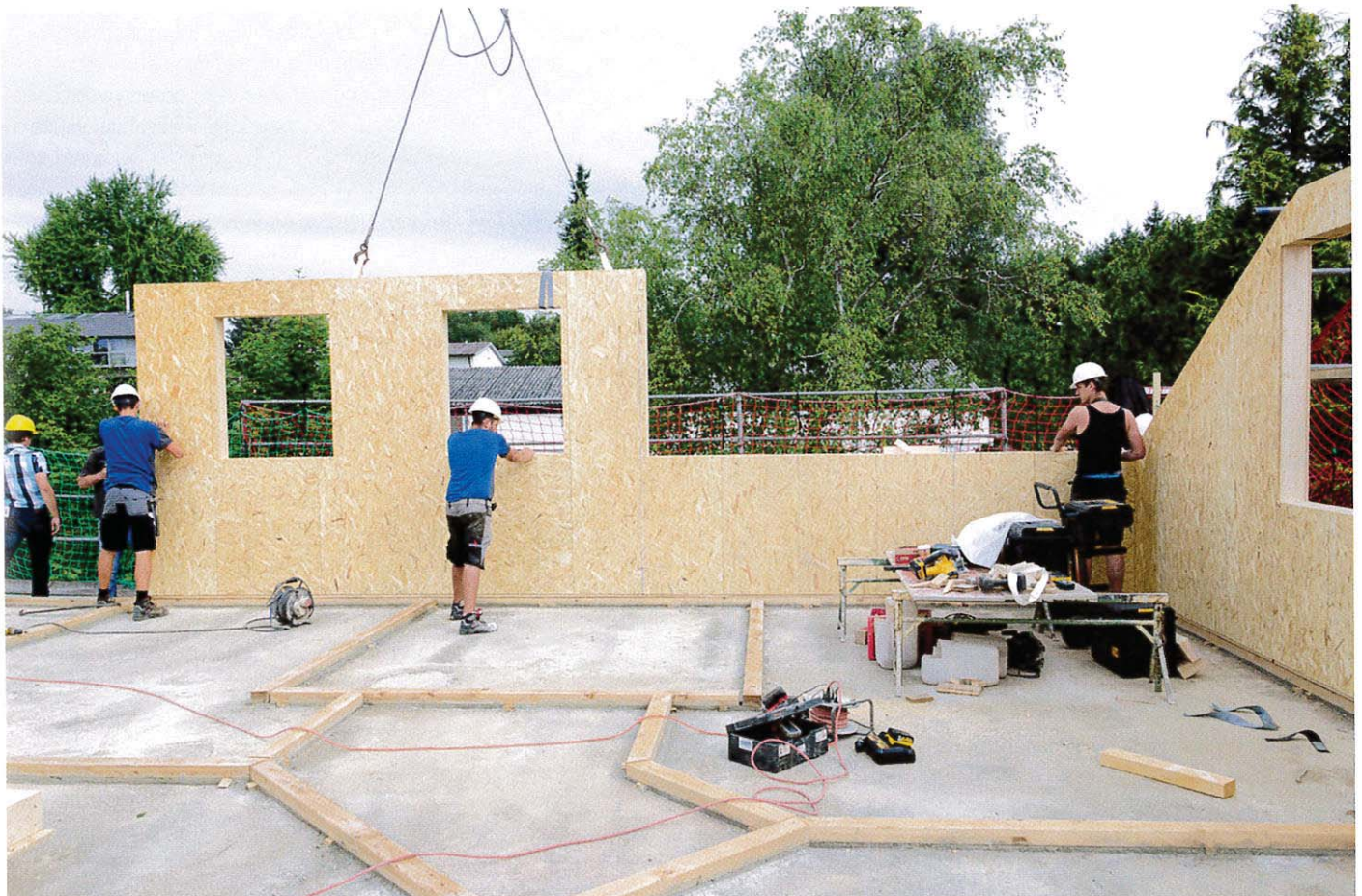
Auf modernen Fertigungsanlagen vorgefertigt, lassen sich die Litec-Elemente auf der Baustelle schnell und präzise montieren.
