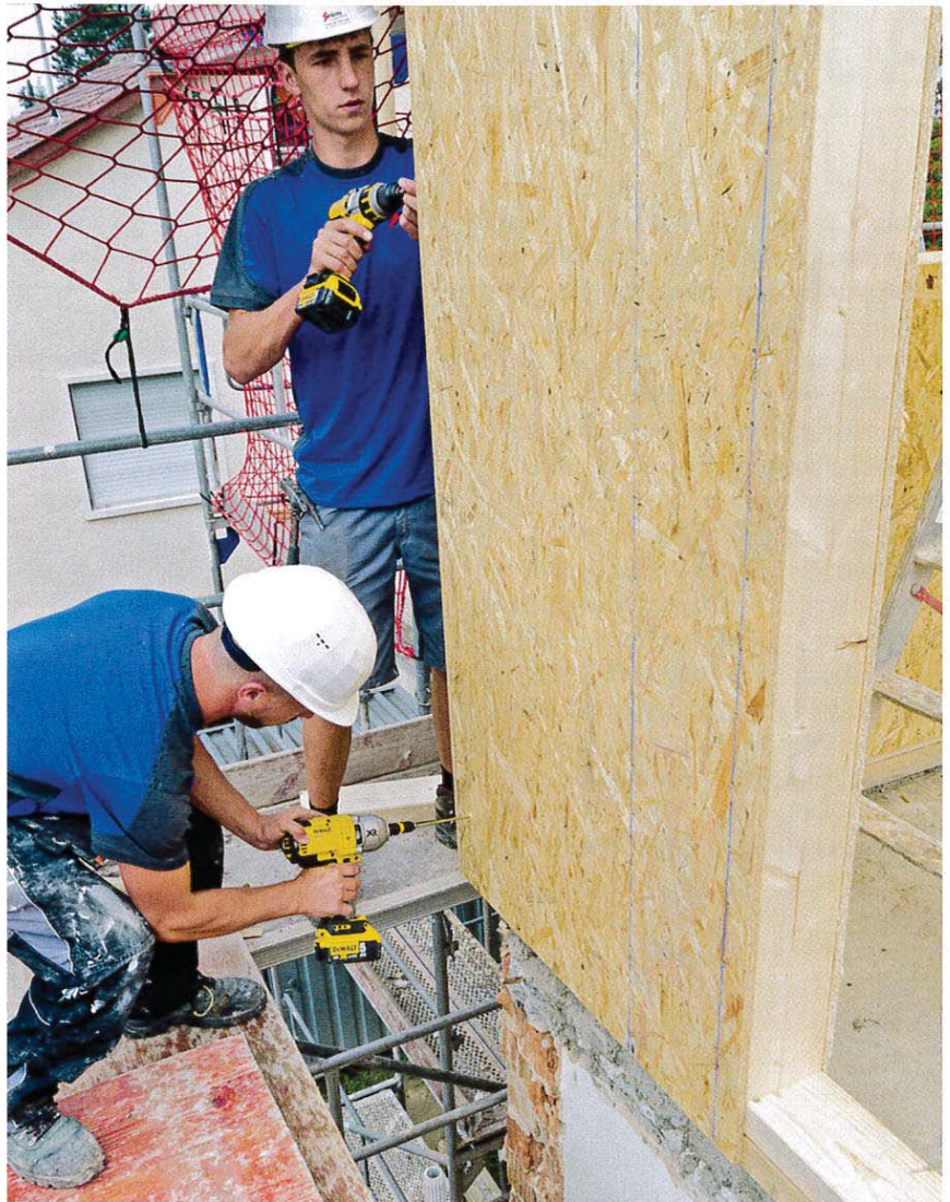
Nach dem Aufstellen werden die Holzelemente ausgerichtet und mit Schrauben fixiert!
