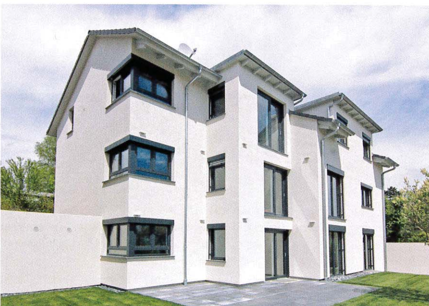
Wie gewünscht sieht man der fertigen Aufstockung nicht an, wie gut sie gedämmt ist.
