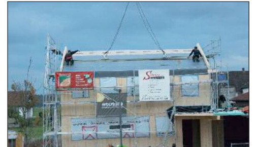
Extra Hebevorrichtungen ermöglichen den problemlosen Transport per Kran an Ort und Stelle.
