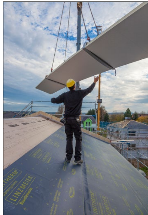
Extra Hebevorrichtungen ermöglichen den problemlosen Transport per Kran an Ort und Stelle.
