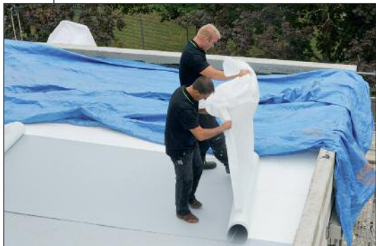
Jetzt auch selbstklebend: Tectofin SK wird nach Abziehen der Schutzfolie vollflächig verklebt.
