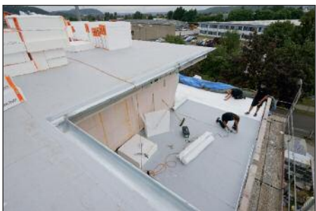
Auf dem Hauptdach wird die Abdichtung mittels Tectofin Verbundblechprofilen direkt bis in die Dachrinne geführt.
