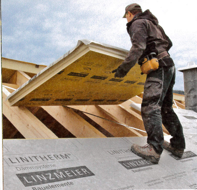
▲ Die 160 mm dicken PU-Dämmplatten wurden auf den Sparren verlegt
