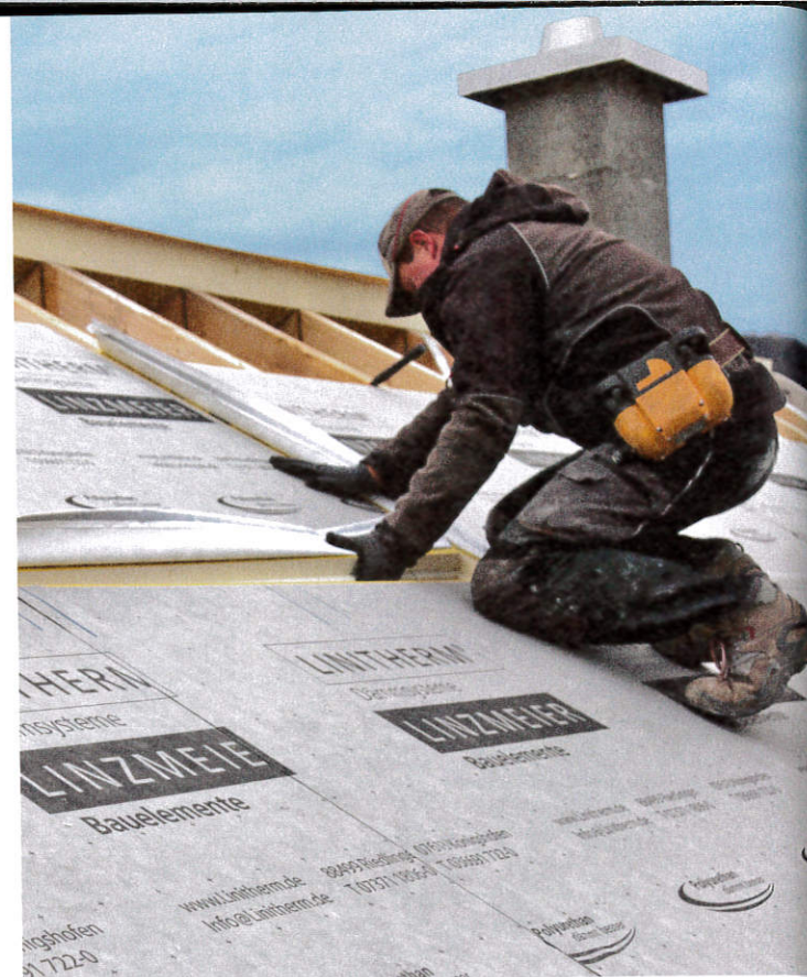
▲ Die Kantenverbindung ist eine Klemm-Press-Verbindung mit Nut und Feder
