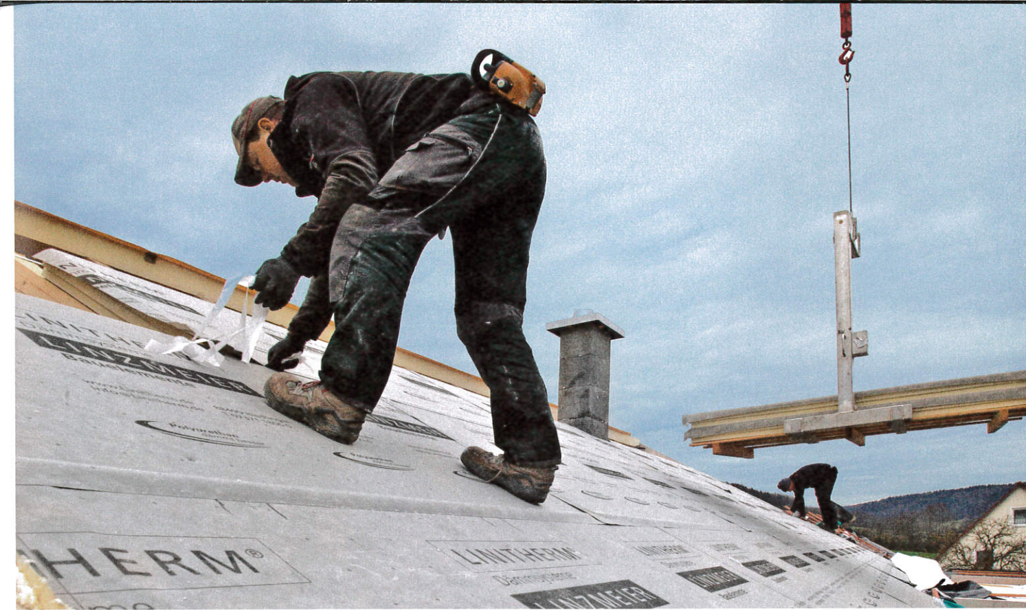
▲ Oberseitig ist die Platte mit einer Unterdeckbahn beschichtet, die rundum um 8 cm überlappt und mit werkseitig aufgebrachtem Dichtband verklebt wurde
