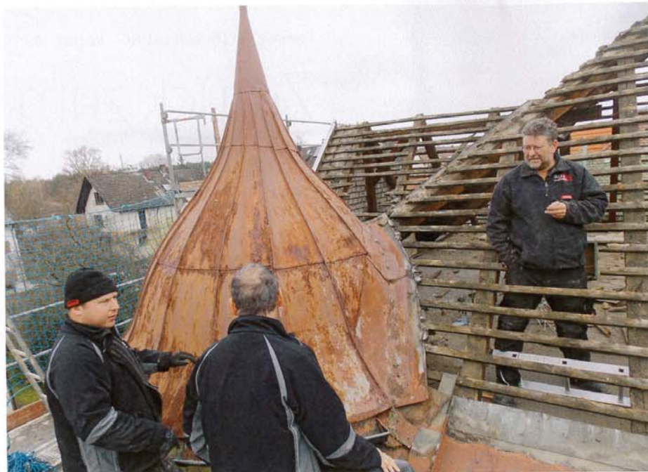
Pause und Baubesprechung nach dem Abriss: Völlig korrodiert zeigten sich die Metallplatten, die in den 1970er-Jahren als Turmeindeckung verbaut wurden.
