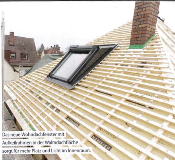
Warm verpackt über dem Sparren: Die 160 mm dicken Aufsparren-Dämmplatten erreichen einen U-Wert von 0,14 W/(m 2 · K).
