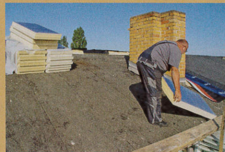
5. Auf der alten Dachpappe wurden dann Hartschaum-Dämmplatten verlegt. Die Randbohle war Anschlag und Abrutschsicherung zugleich.
