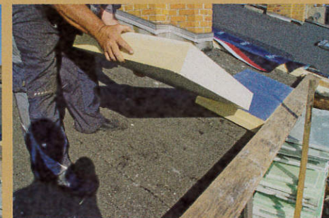
6. Mit ihrer sich überlagernden Kantenausbildung (Stufenfalz) liegen die Elemente im Verbund wärmebrückenfrei auf der Dachfläche.
