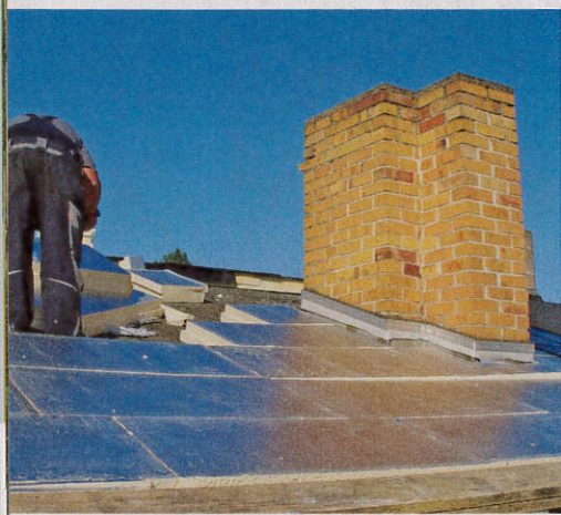
7. Und so schloss sich die erste Dachhälfte relativ schnell. Die Dämmelemente sind leicht und lassen sich auch gut bearbeiten.
