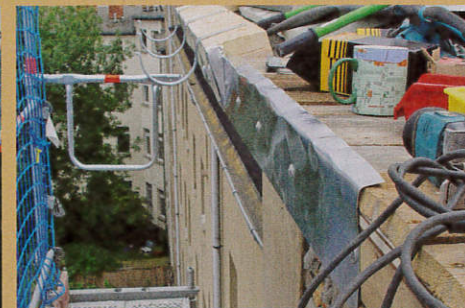
3. ... aus Zink abgedeckt, die dann weit nach unten reichen. Die hier noch unterhalb sichtbare Regenrinne wurde im Zuge der Sanierung ...
