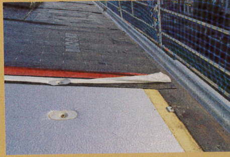
10. Nun folgte die Abdichtung mit Selbstklebe- Bitumenbahnen. An der Traufe laufen diese bis über die Bohle und das Wassereinweisblech.
