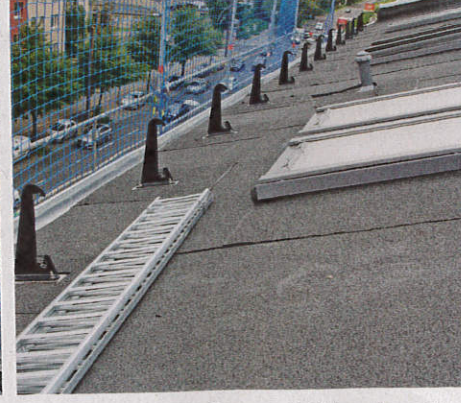
16. Hier oben waren dann noch Schneefanggitter erforderlich. Die Tragplatten für die Halterungen wurden zuvor in der Bitumenhaut integriert.
