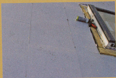
9. Die Fenster wurden schon beim Innenausbau höhergesetzt, sodass die Dämmung nun in richtiger Höhe anstieß. Fugen wurden ausgeschäumt.
