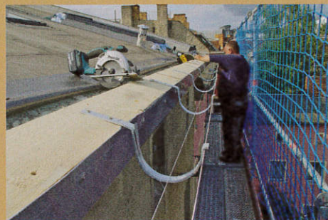
4. ... erneuert. An den Bohlen befestigte Rinnenhalter wurden mit seitlichem Gefälle angeordnet. Eine gespannte Schnur half beim Ausrichten.
