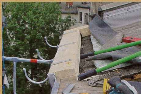
1. Dort, wo die Dachfläche bis zur Traufe als Dach blieb – also nicht im Bereich der Dachterrasse – wurden Holzbohlen als Abschluss angebracht.
