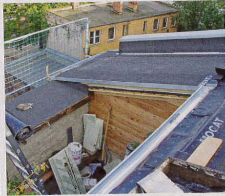
15. Blick über die Dachkanten hinunter auf die Dachterrasse. Rechts erkennt man die erhöhte Brandmauer mit hochgezogener Bitumenbahn.
