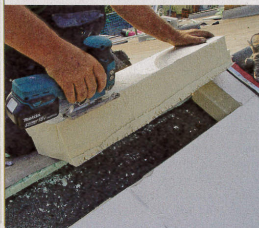
8. Oben am First wurden die letzten Stücke mit der Stichsäge schräg zugeschnitten, damit später die Dämmelemente der anderen Dachschräge genau anschließen können.
