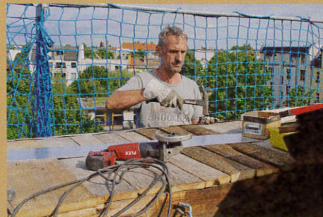
2. Hier erkennt man am Ausschnitt für die Dachterrasse noch den alten Bretterboden. An der Außenkante wurden die Dielen mit Blechen ...
