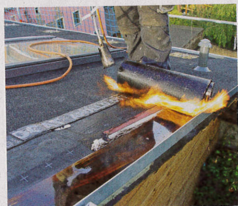
14. Sie wurden mit der Flamme verschweißt. Am Dachrand zur Dachterrasse dient eine Zinkblechaufkantung als sauberer Abschluss.
