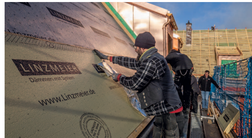
▲ Auf der Traufbohle startend, wurden die PU-Dämmelemente auf der Baustelle von unten nach oben verlegt
