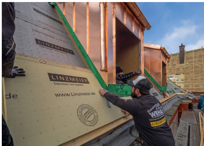
◀ Anschluss an die Fertiggauben: Auch hier war es von Vorteil, dass sich die Dämmplatten auf der Baustelle exakt zuschneiden ließen
