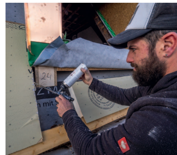
▲ Hier galt es sauber zu arbeiten, um eine homogene Dämmebene über der alten Holzkonstruktion zu bilden
