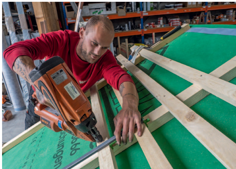
◀ Im nächsten Schritt wurden auf der Gaube Konterlattung und Lattung montiert
