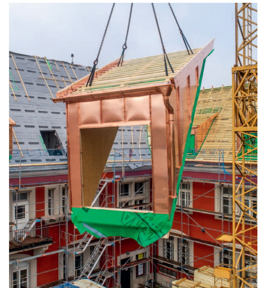
▶ Fertiggaube am Haken: Die großen Elemente wurden auf der Baustelle mit dem Kran vom Lkw auf das Dach gehoben
