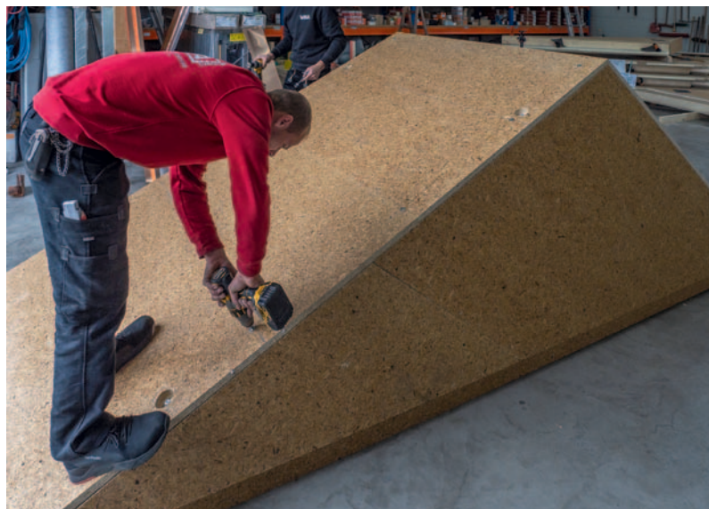
◀ Die Elemente ließen sich ohne Probleme mit dem Akkuschrauber verbinden
