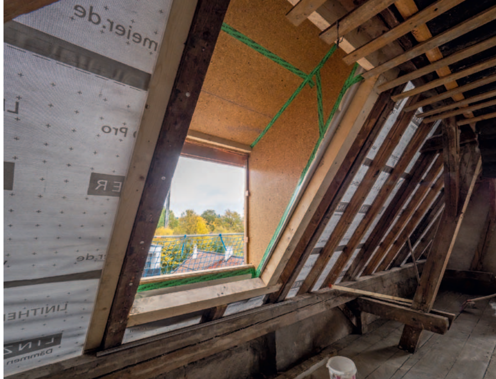
▲ Gut geplant: Dank der Gaubenvariante mit integrierten Montageschwellen konnten die Fertiggauben direkt auf die Sparren gesetzt werden
