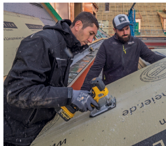
▲ Die Dämmplatten lassen sich mit handelsüblichen Werkzeugen schneiden, drehen und auf der anderen Seite wieder anlegen
