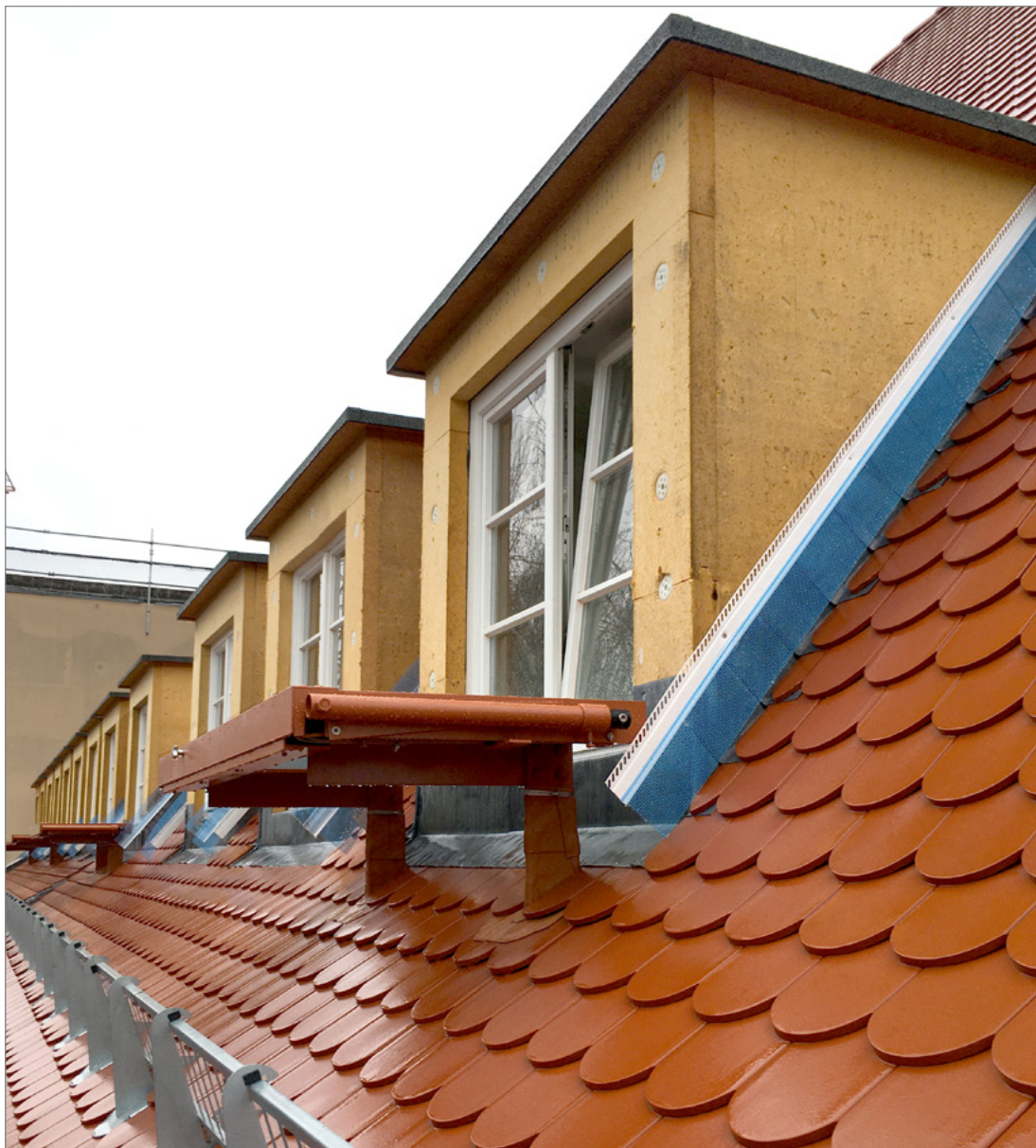
Beispiel einer Fluchtweggaube mit Austrittsrost vor dem Fenster
