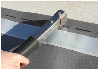
Verlegung allgemein – Befestigung auf Schalung oder Sparren mit Tacker
