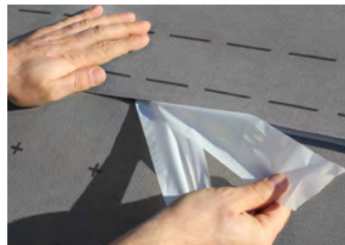
Verlegung allgemein – Verklebung nass in nass; beide Liner abziehen und gut andrücken - ggf. Rolle oder ähnliches verwenden.
