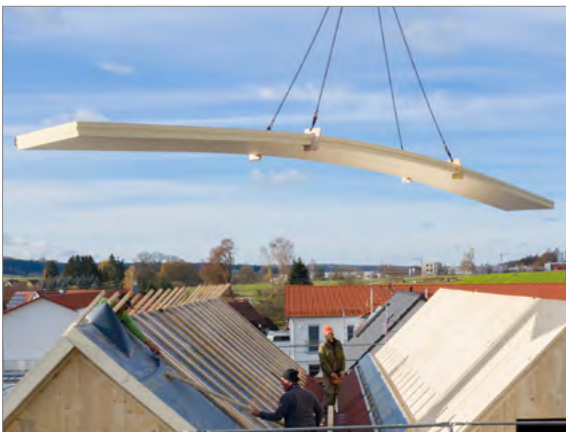
3. Krankette in die Kranschleufen anhängen, sodass die Platten waagrecht am Kran hängen. Die Ketten vorsichtig anziehen, sodass die Hebehilfen mit gleichmäßiger Lastaufnahme an der Dämmplatte verkanten.
