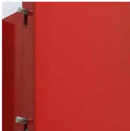
Blechkantenteile für hinterlüftete Fassadenkonstruktionen
