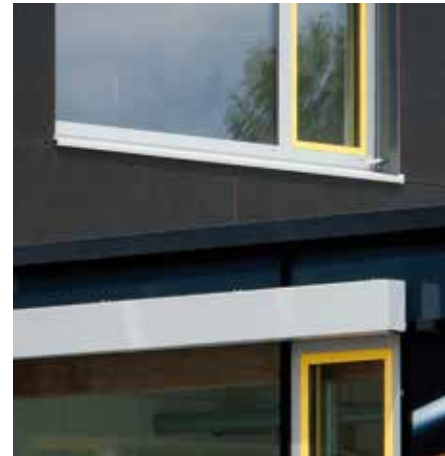
Jalousieblenden und Fensterbänke
