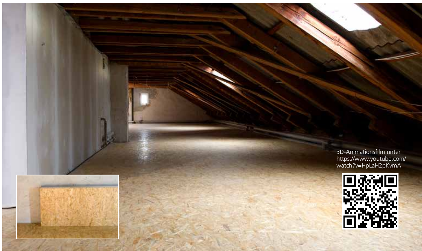
LINITHERM Dachbodenelement PAL oder PGV LINITHERM L+D-Folie Holzbalkendecke Sparren
