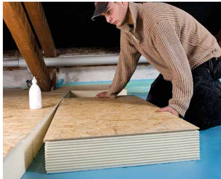
LINITHERM Dachbodenelement P OSB bzw. P OSB Plus LINITHERM L+D-Folie Holzschalung Mineralfaserdämmung zwischen den Sparren raumseitige Bekleidung
