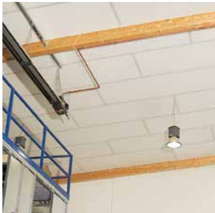
Kellerdeckendämmung unter Betondecke
